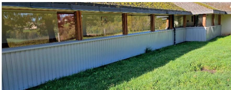
L'isolation extérieure du mur du pignon nord a été réalisée en 14 cm d'épaisseur avec un enduit de finition et un faux plafond en lames dans la zone de séchage du linge par l'entreprise Veau-Bretelle à Ussel... Enfin, deux brise-vent en aluminium ont été mis en oeuvre avec des lames verticales posées sur profils hauts et bas, côté nord par l'entreprise BRL Lachenaud de Saint-Pardoux-le-Vieux.
