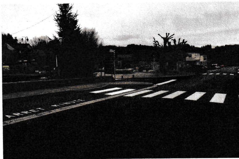
Les tracés des chemins piétons, stops et arrêt minute ont été réalisés par les agents municipaux pour garantir la sécurité de tous.
